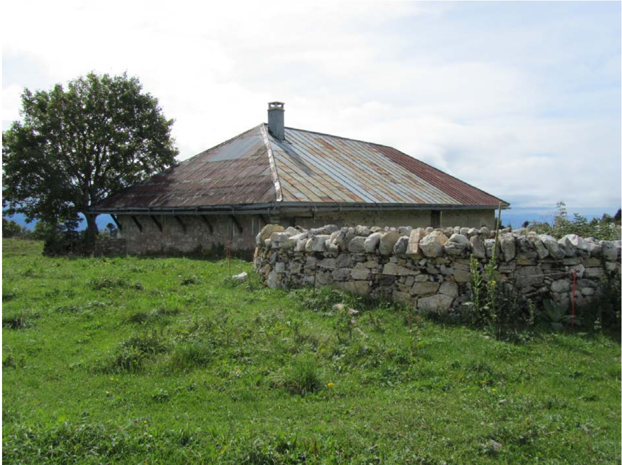
L'arrière du chalet, avec le mur de pierre sèche circulaire entourant la citerne.
